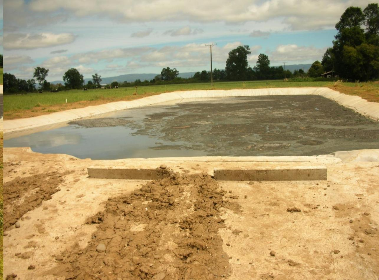
**Pozos recubiertos con PEAD (Polietileno de Alta Densidad)**
